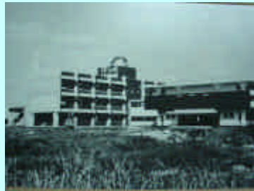
建設当時の管理棟と第1研修棟
