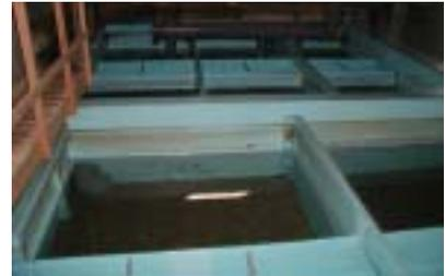
写真9 黒潮大水槽の砂ろ過槽
