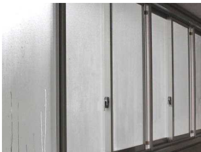
図5 廊下の窓の様子
