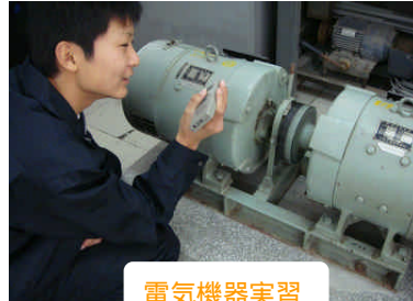
電気機器実習
