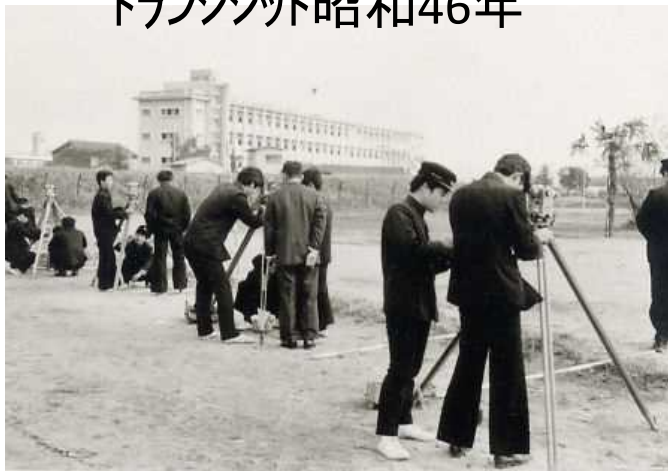
実習風景 建築科 トランシット 昭和46年
