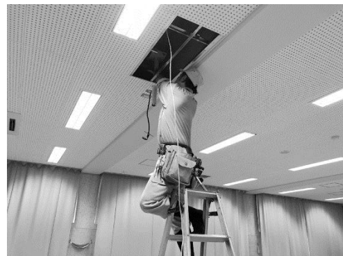
プロジェクタ設置のための配線作業（社員の方）
