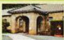
旧集成館機械工場
