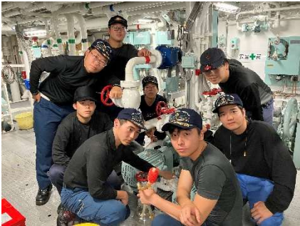
機関室で燃料ポンプの保守点検をする機関技術科の実習生 六月二十四日
