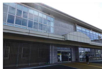
写真6 放送局の設置場所
