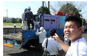
写真4 非常用発電機設置訓練
