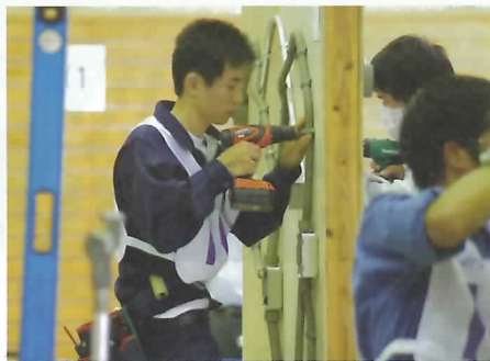
電気工事部門
