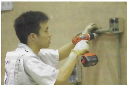
電気工事部門
