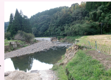
コース上の橋と道路の崩落箇所
