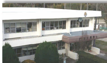
(2月下旬・管理棟外壁工事完了!!)
