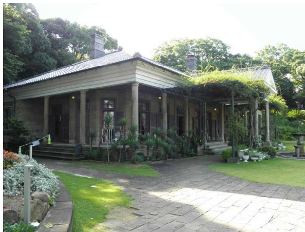
旧オルト住宅(1865年建築) 日本最古の石造り住宅とも
