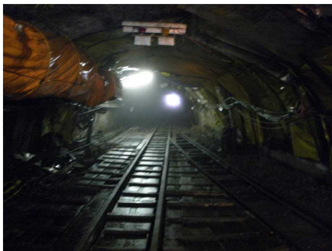
坑道内は湿度が高く, トロッコのほかケーブル等が多数設置
