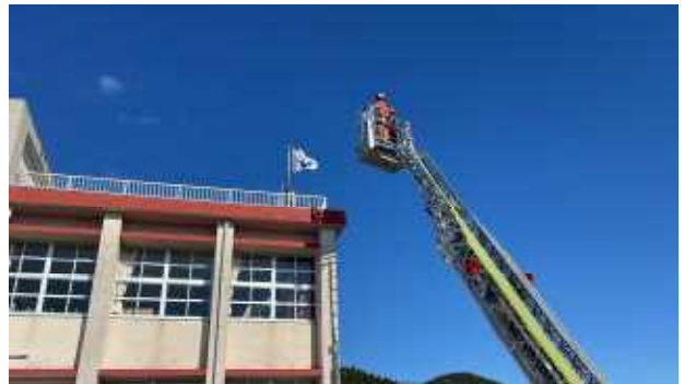
1号館の屋上(地学室の上)に接近
