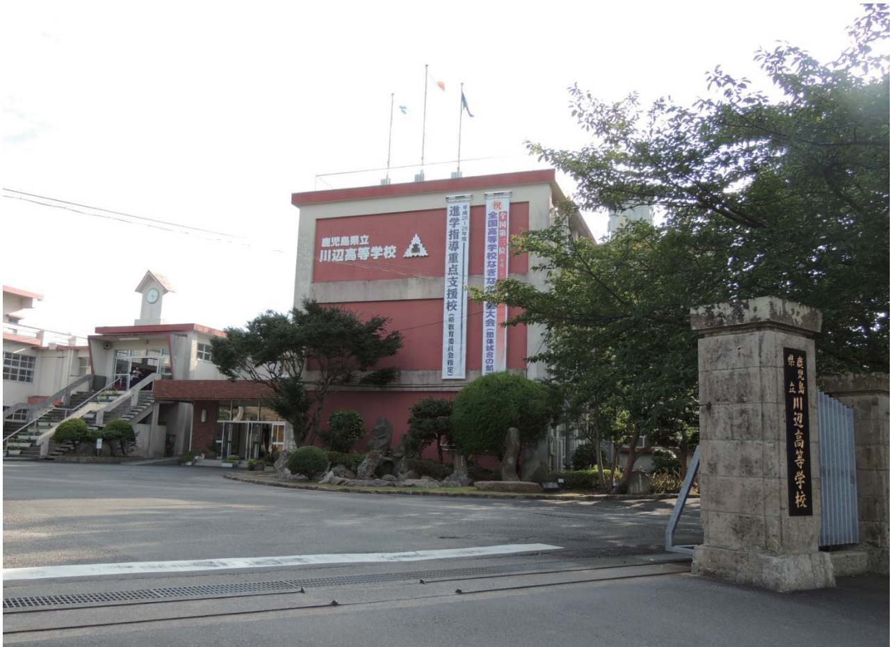
校舎に川辺高校のロゴ & 懸垂垂れ幕の新設
