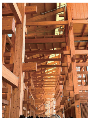
写真1 大屋根リング 内観
