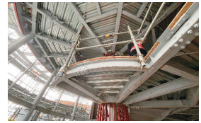
写真7 鉄骨骨組建方時の状況2
