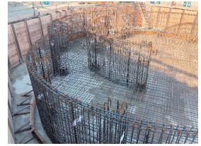
写真8 基礎工事の状況
