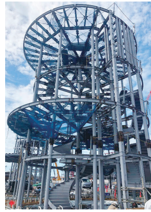
写真6 鉄骨骨組建方時の状況1
