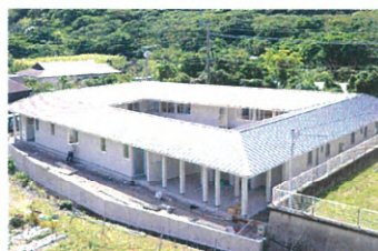
清雲寮(女子寮) 令和2年4月完成
