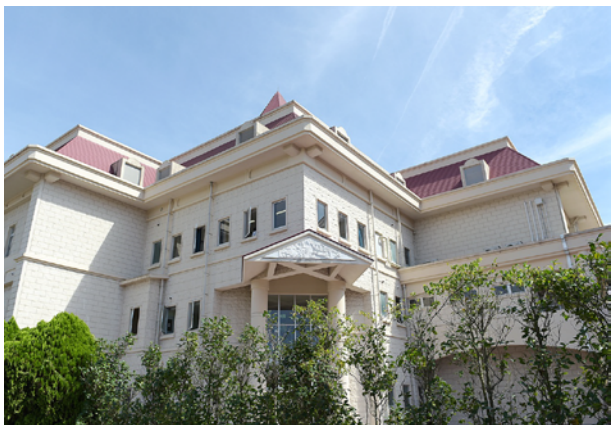
芸術棟。3 階建ての校舎には音楽科と美術科の専門の授業で使用するレッスン室や実習室が設置されている。
