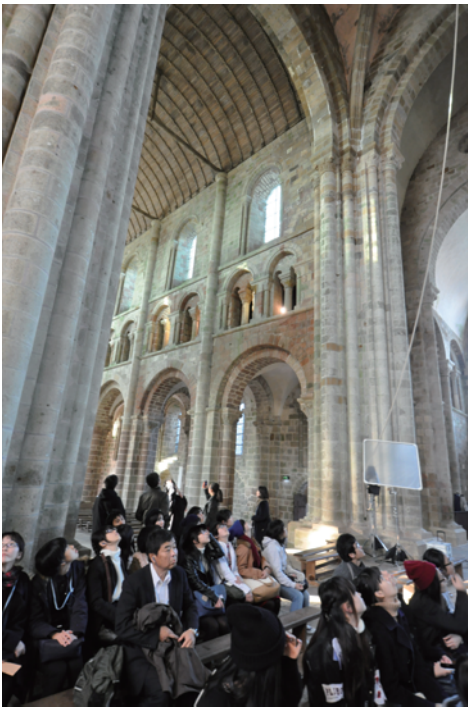
永い年月を経て建設された教会は、ロマネスクとゴシックの二つの様式が混在していて歴史の深さを感じる。
