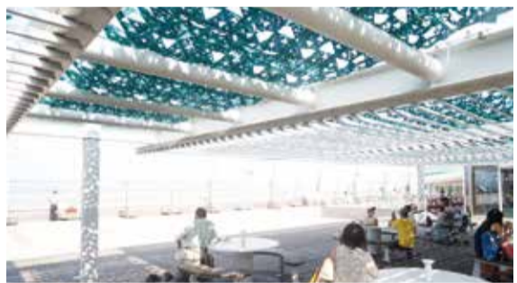
羽田空港第二ターミナルに設置された「フラクタルひよけ」
