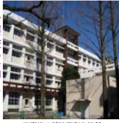
工事後の新装東側生徒館
