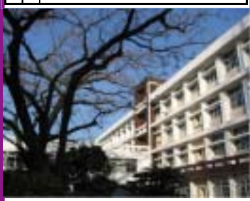
中庭から見た西側生徒館
