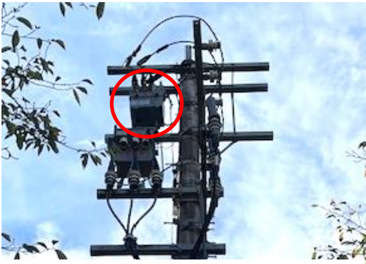
区分開閉器 (気中負荷開閉器)
