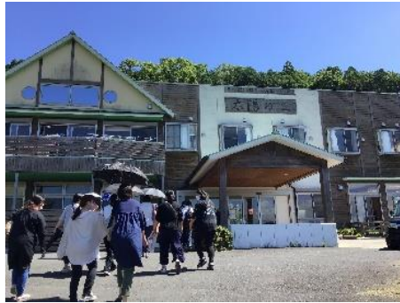
グループホーム棟
